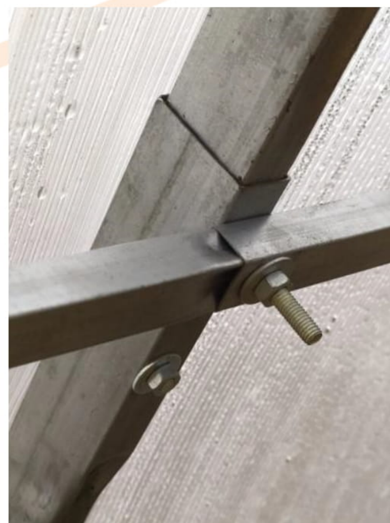
6 pav. Lankų ir skersinių padėtis juos sujungiant
